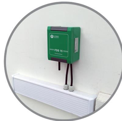
Zur Überwachung des Feinstaubgehalts auf dem Betriebsgelände des Unternehmens SNF Floerger wurde an der Außenwand eines Bürogebäudes ein FDS 15 angebracht. Mit Hilfe dieser Außeninstallation soll sowohl die eigene Produktion kontrolliert als auch der tatsächliche Feinstaubgehalt der Umgebung überwacht werden.
